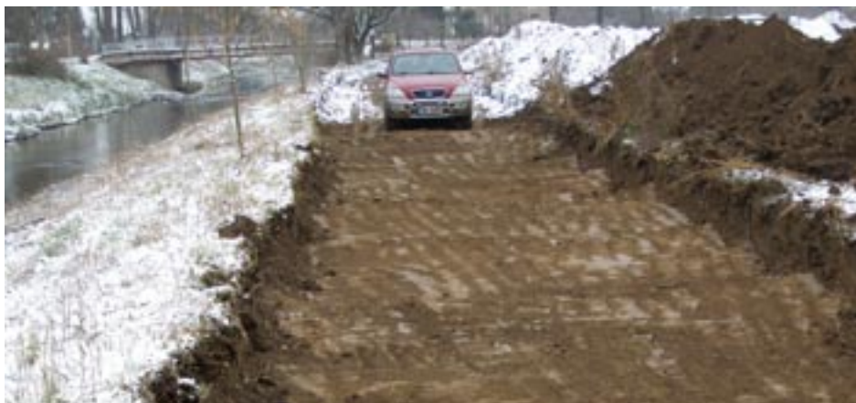
Skrývka přístupové komunikace na stavenišť ČOV za ZEMSPOLEM
